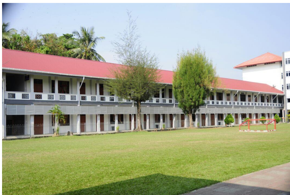
图（二十二）1954 年启用之 14 间钢骨水泥教室现貌
