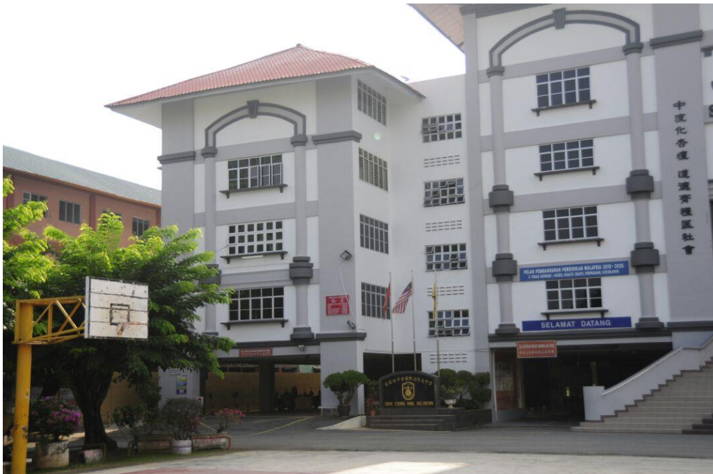
图（二十七）宏愿楼第一期工程（左翼）
