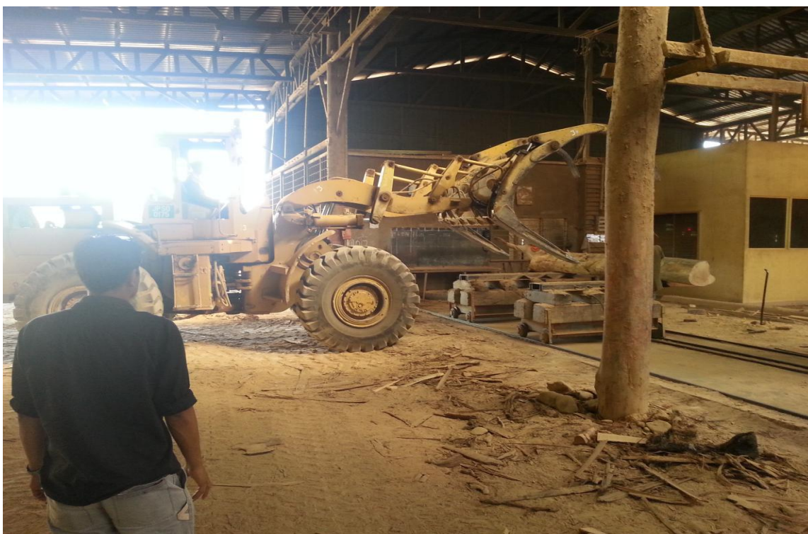
图七：WHEEL LOADER 966 CATERPILLAR 进行切割
