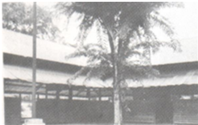
图 5：1948 年临时建起的六间白锌板教室
