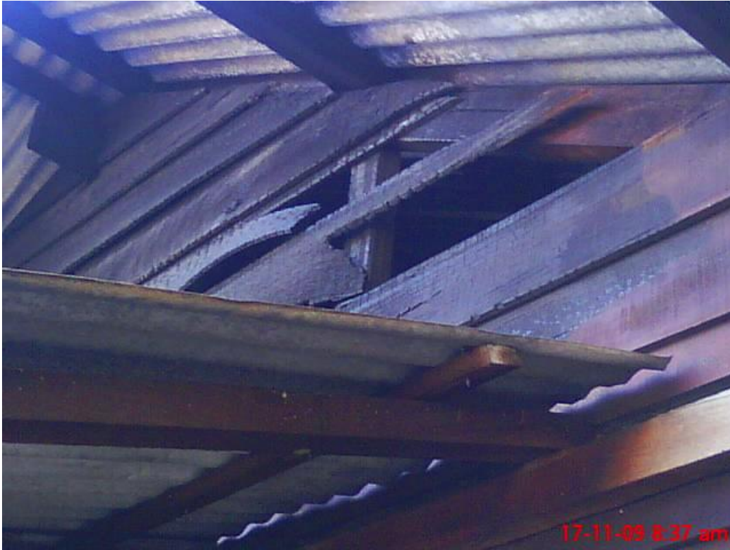
【图 29】火烧住家照。此为 2009 年 11 月 17 日，李德发住家的左上方。此图显示因隔壁家火患所殃及的地方。
