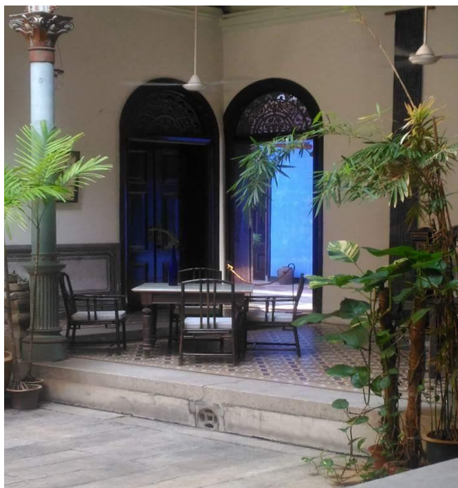
图 4-10 天井处的金钱造型排水出口 (笔者摄于 2014 年 5 月 1 日于张弼士故居)
