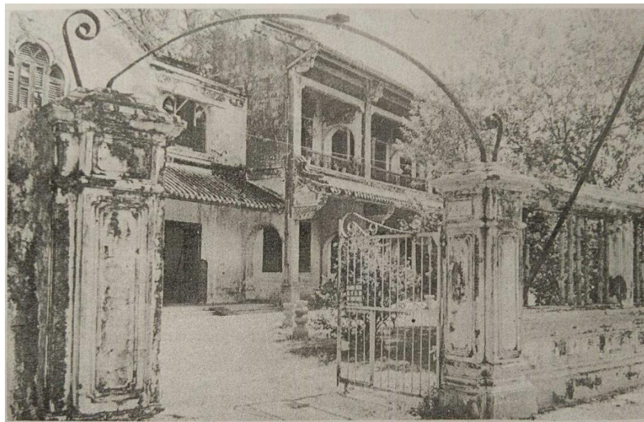
图 4-17 年久失修、残破不已的大宅 （笔者翻摄自《通报》1988年6月19日）
