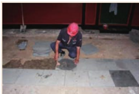
后堂楼方砖地面铺墁
