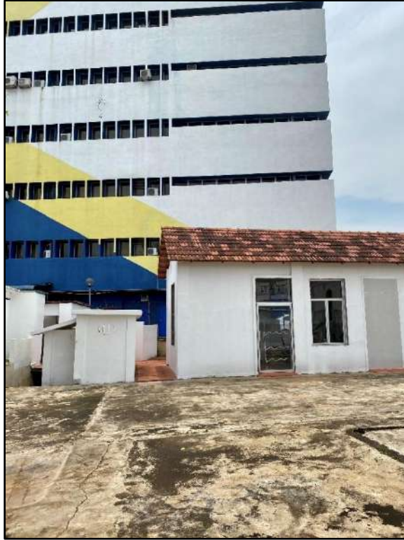
图 4.11：旅馆地板下被填上的水井 365
