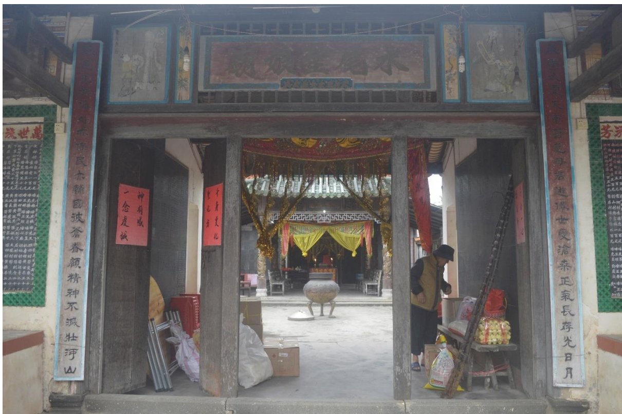
图 3 东郊镇桃李村水尾圣娘庙前门外观。（郑翔鹏摄于 2017 年 11 月）
